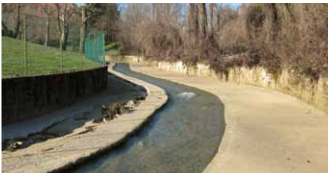
Torrente Lesina in comune di Bonate Sotto: tratto fortemente artificializzato, con sponde e fondo dell'alveo rivestite da calcestruzzo. (foto E. Morlotti)
