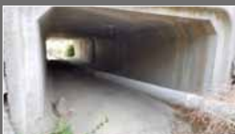
A sinistra sottopasso per piccola fauna, migliorabile rinaturalizzando il sedime; a destra sottopasso del torrente Dordo, migliorabile rinaturalizzando le sponde.
