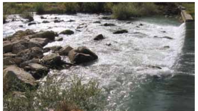
Scivolo in massi realizzato lungo un affluente del fiume Adige a Trento: esempio di conversione di una briglia tradizionale al fine di garantire la continuità ecologica del corridoio acquatico. (foto E. Morlotti)
