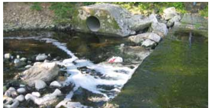
Guado sul T. Grandone, in comune di Medolago: presenza di una discontinuità del corridoio acquatico rappresentata dal salto di fondo a valle del guado, e presenza di schiume che evidenziano la scarsa qualità delle acque. (foto E. Morlotti)
