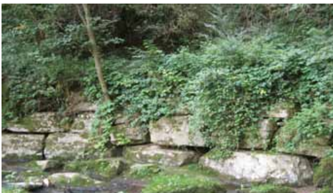
Scogliera viva lungo il T. Grandone in comune di Solza: esempio di opera di ingegneria naturalistica presente in un tratto in curva del torrente, realizzata circa 20 anni fa. (foto E. Morlotti)
